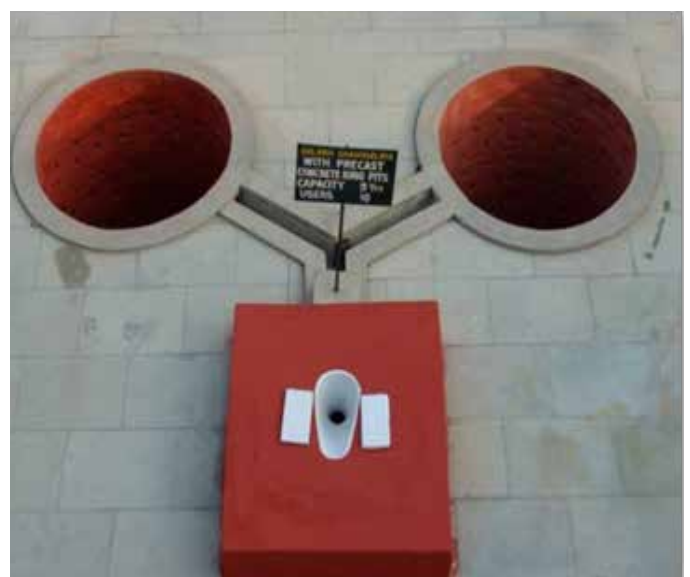
Sulabh Two Pit Pour Flush Toilet
